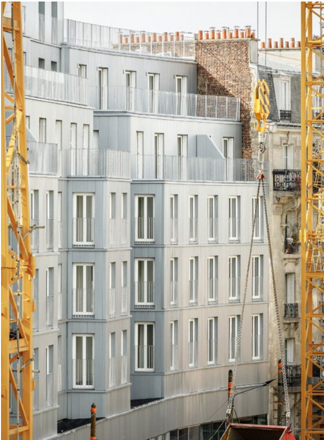
Raccord entre l'existant mitoyen et le projet.
